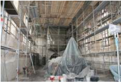
Die eingerüstete Pfarrkirche
