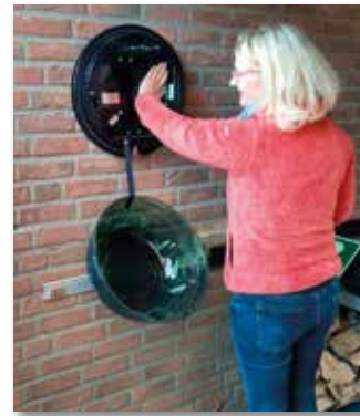
Annette Freitag prüft die Wärmeabgabe der installierten Heizung.
